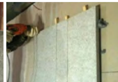
파이버락 에폭시 본드 시공
